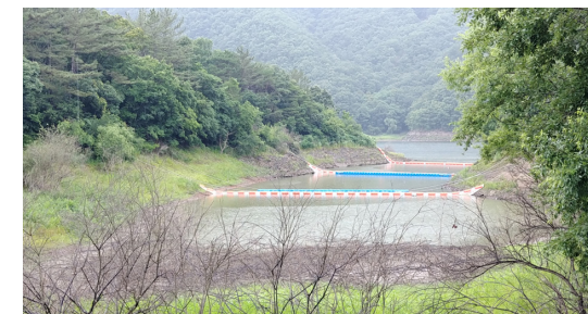
현장 규모(2,000 m 2 ) 실증화 설비 전경
