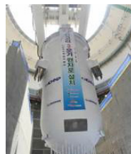
신고리 3호기 원자로 설치
